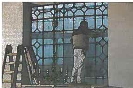
Een restauratieschilder vervangt de verflaag op de stalen kozijnen.
